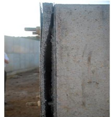
Parete in cemento armato protetta dal pannello di mitigazione dell'esplosione:
