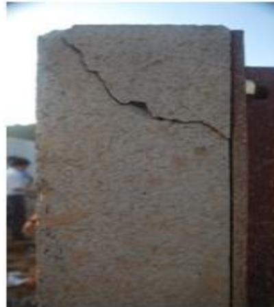
Parete in cemento armato non protetta dal pannello di mitigazione dell'esplosione:
